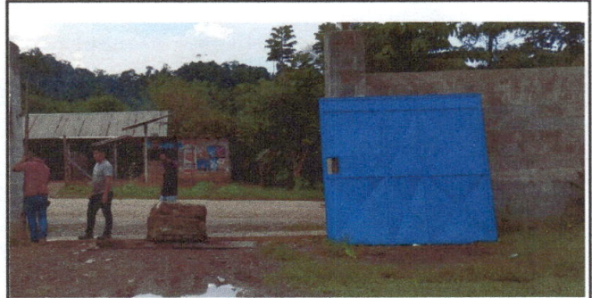
Foto 4: Instalación de Portón metálico en la entrada del establecimiento
