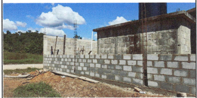
Foto 2: Mejoramiento de muro perimetral
