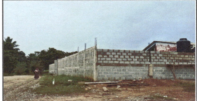
Foto 6: Mejoramiento de muro perimetral.
