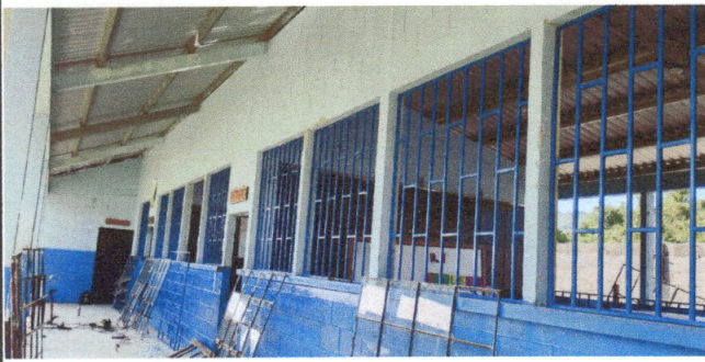
Foto1: Instalación de balcones en módulos de aulas.
