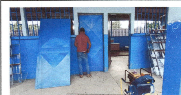
Foto 5: Sustitución de puertas metálicas.
